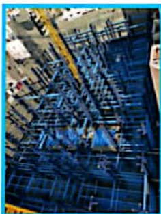
ساختمان مرکزی بنیاد شهید
