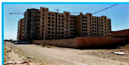
پروژه مس سرچشمه
